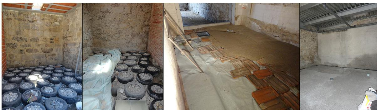
**Fig. 21.** Pneus aplicados com o cascalho no seu interior. **Fig. 22.** Manta geotêxtil a cobrir os pneus. **Fig. 23.** Telhas a fazer a caixa-de-ar e terra a cobrir. **Fig. 24.** Pneus enchidos a betonilha pronto a ser aplicado o pavimento final.
