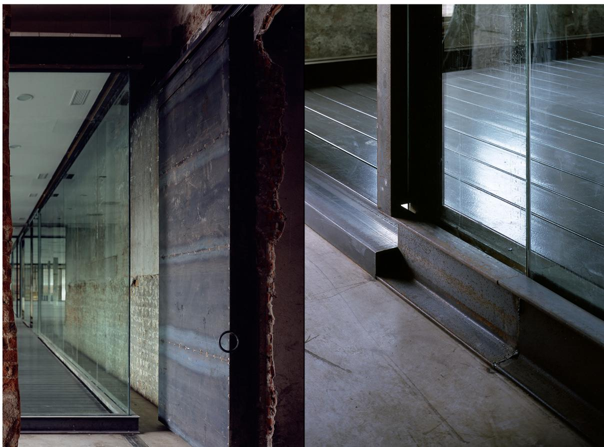
**Fig. 16.** Caja conformada con perfiles de acero y vidrio en la sala longitudinal de la nave 17c-intermediae. [Fuente: del autor, Arturo Franco]
