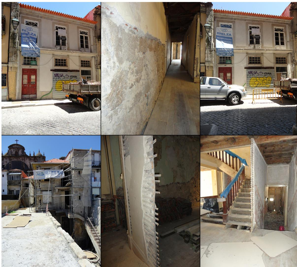
**Fig. 12.** Fachada principal do edifício com exemplo da parede de meação com o edifício vizinho à esquerda da porta de entrada. **Fig. 13.** A mesma parede de meação vista de dentro, com revestimento retirado até à alvenaria de pedra. **Fig. 14.** Fachada principal. **Fig. 15.** Fachada Posterior. **Fig. 16.** Parede interior de tabique simples. **Fig. 17.** Parede interior de escada de tabique simples.
