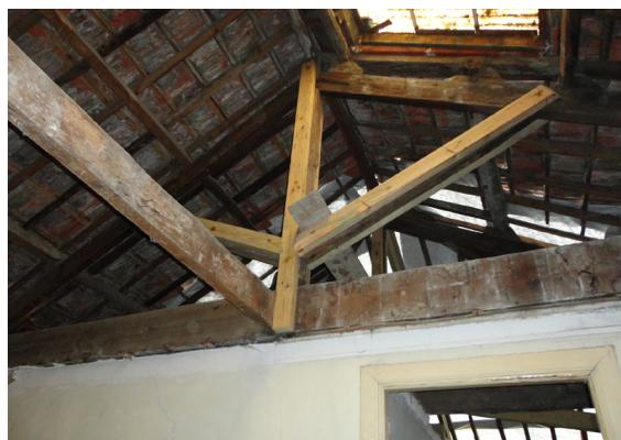
**Fig. 33.** Exemplo de estrutura com elementos novos e antigos juntos.
