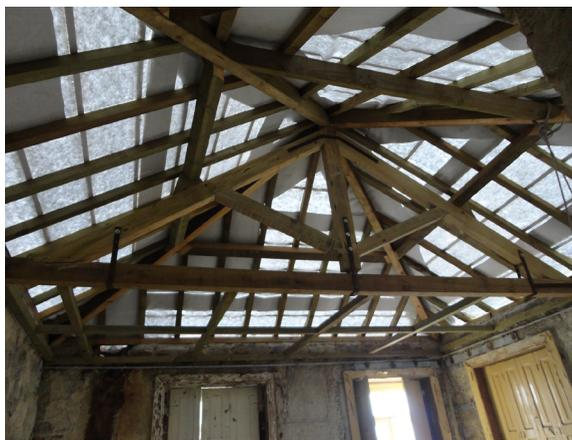
Fig. 34. Estrutura corpo 2 toda refeita na íntegra.
