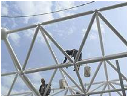
Protecção anti corrosão e fogo de estruturas metálicas
