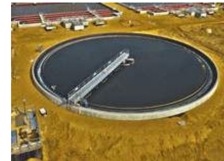
Revestimentos de reservatórios/tanques e instalações de tratamento de águas
